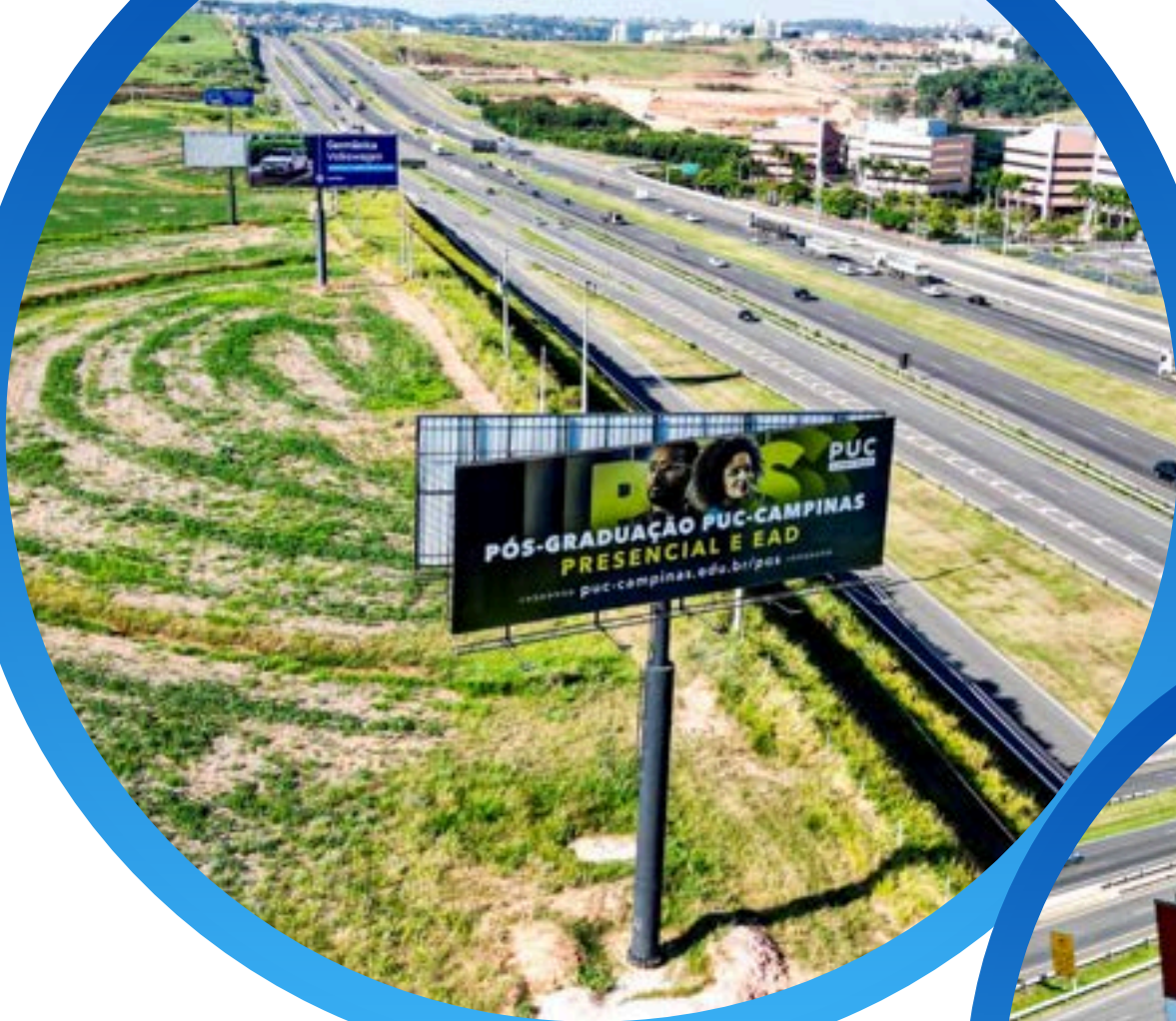
CAM5 Rodovia Dom Pedro (km 131+800m Norte)
